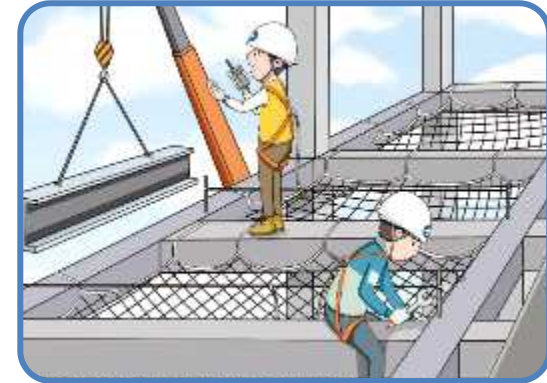
6 안전대 착용 시 안전대 부착설비 설치
