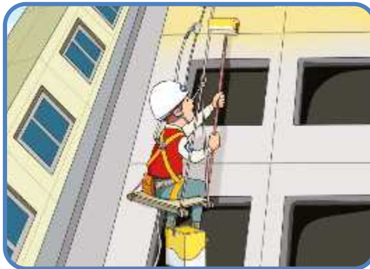
5 달비계 작업 시 안전대 및 구명줄 설치
